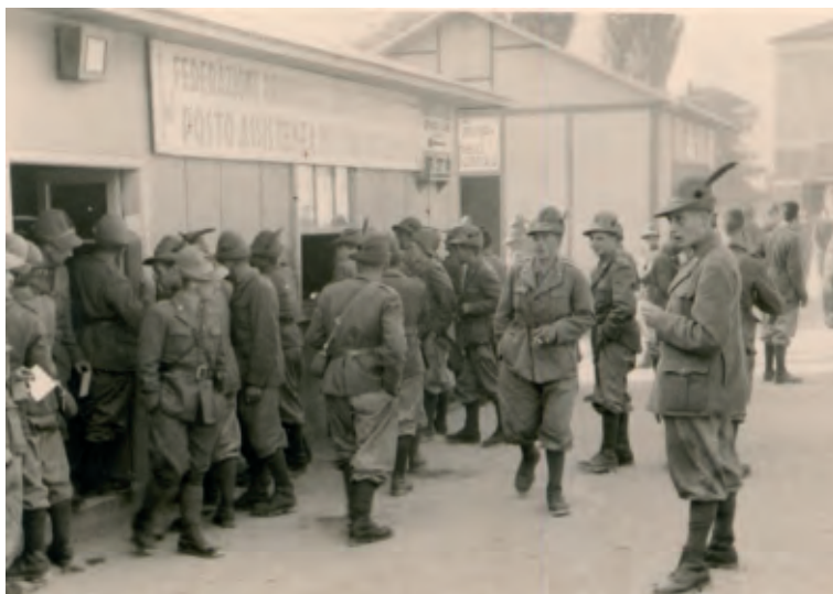
Transito. (La partenza per il fronte Est).
