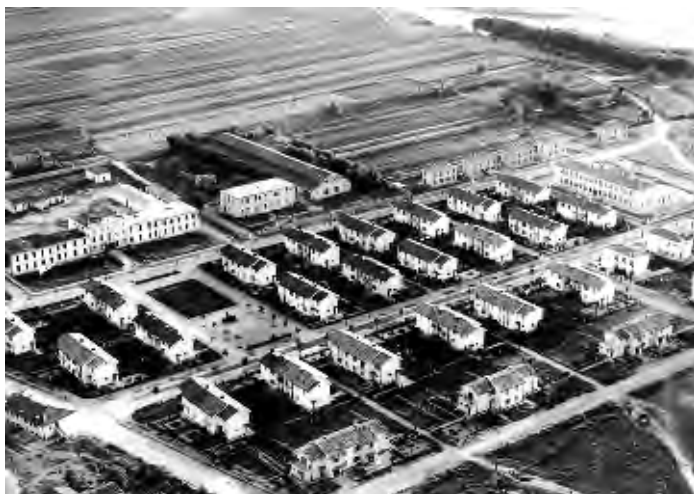
La caserma di Campagnuzza utilizzata dal 9° Reggimento Alpini. In seguito venne costruita una nuova caserma in Via del Monte Santo (1942).
